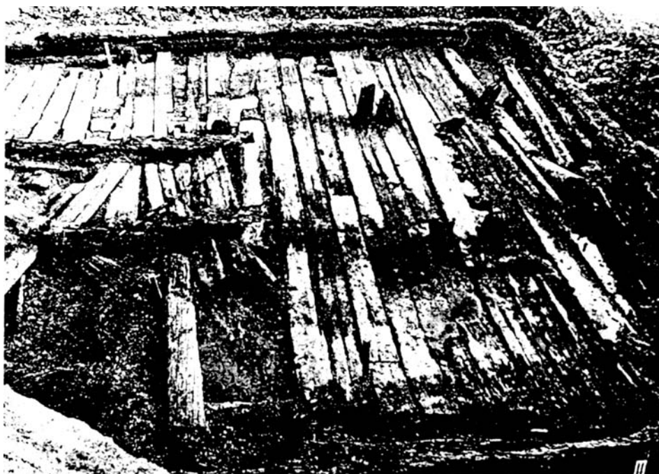
Рис. 126. Деревянная мостовая конца 14 в., вскрытая при раскопках Старицкого городища
